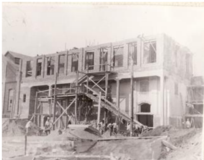
Construcția noii Uzine de apă (1931-1934)
